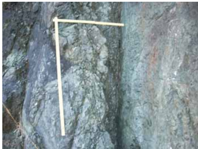
資料写真 2-2-1 通称 F5 断層の破碎部の状況（資料図 2-2-1 の P14）
