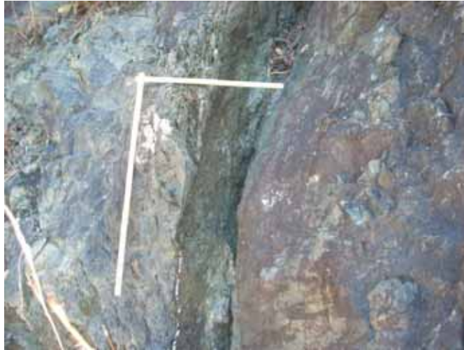
資料写真 2-2-2 切土法面下段では通称 F5 断層の北西部断層の状況(資料図 2-2-1 の P11)
