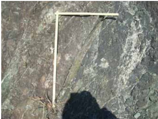
資料写真 2-2-3 切土法面中段の F5 断層とその北西部断層の結合部(資料図 2-2-1 の P15)
